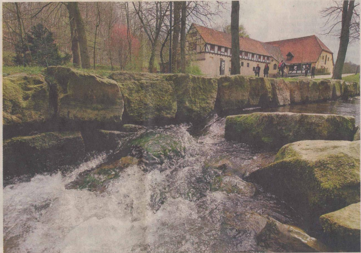
Sprudelndes Wasser: An der Fischtreppe an der „Oberen Mühle“ sind Fundamente unterspült worden, was teilweise zu Einstürzen führte. Die Stadt hat die Treppe wieder repariert – und stellte dabei Baumängel fest.
